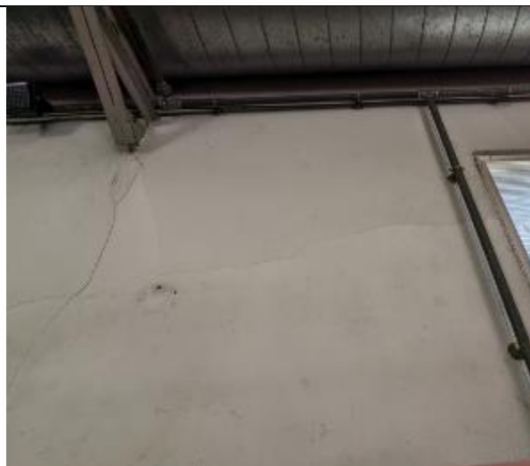
Figure 2: Fissure sur mur de façade lié aux tassements
